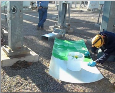
Corte una pieza de PileMedic™, aplique el epóxico y aplique ...
