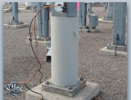
Retire las correas y pinte el encamisado (si se desea)
