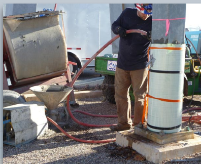
Coloque mortero, utilizando vibrador, llenando el espacio anular.
