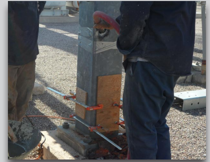
Llene el interior de la columna con mortero.
