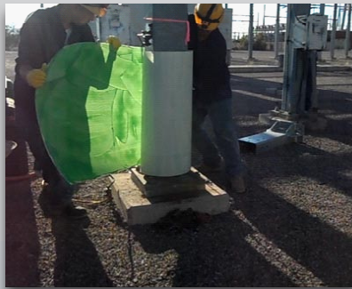
... alrededor de la columna para crear así un encamisado de 36-pulg de alto
