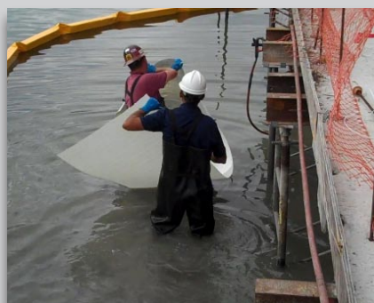
Tansporte la lámina de PileMedic™ dentro del agua
