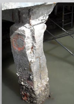
Columna deteriorada
