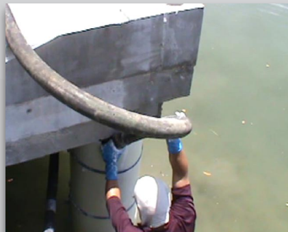
Prepare y vierta el mortero para llenar el espacio anular entre el encamisado y la columna
