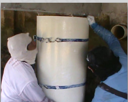
Coloque un par de correas alrededor del encamisado para proveer soporte temporal
