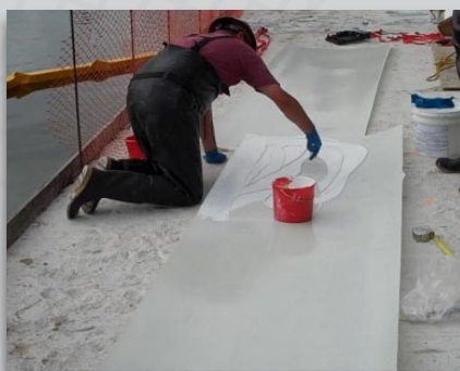
Prepare la resina QuakeBond™ 220UR (resina de uso bajo el agua) y aplíquela en la cara posterior de la lámina de PileMedic™ con una capa de espesor de alrededor 30-40 mil (0.80 a 1.0 mm)
