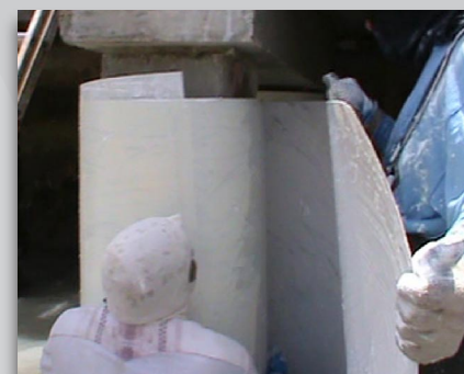
Coloque la lámina de PileMedic™ alrededor de la columna deteriorada para crear un encamisado cilíndrico de dos capas
