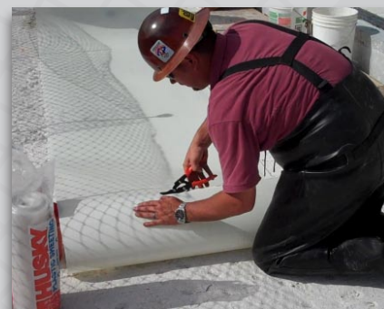
Corte lámina de PileMedic™ al tamaño deseado
