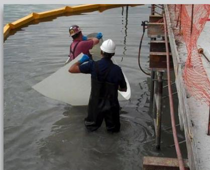
Transporte la lámina de PileMedic™ dentro del agua
