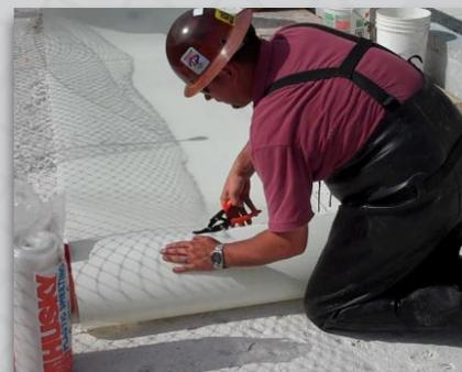
Corte lámina de PileMedic™ al tamaño deseado
