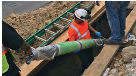
... antes de que la tubería reparada se tapara y probara bajo presión de fluido interno.
