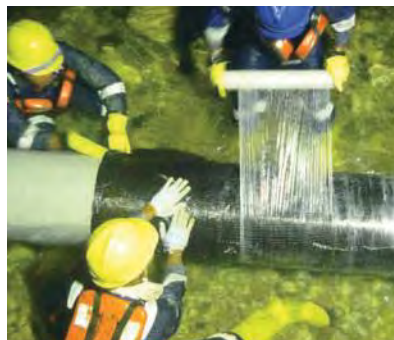
Reparación externa de tubería de petróleo sumergida en agua con QuakeWrap.
