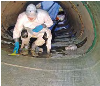
Reparación de juntas en alcantarillas ovaladas de hormigón.
