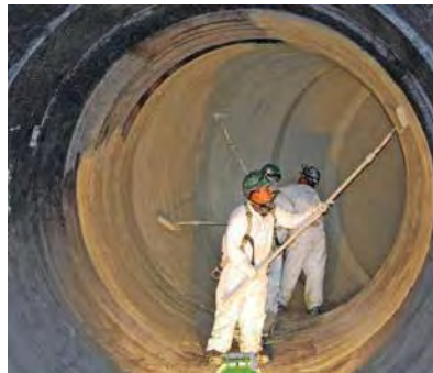
Revestimiento superior de CFRP en PCCP de gran diámetro.
