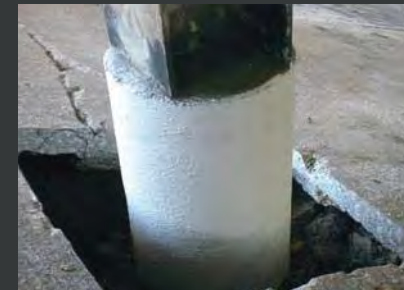
Sección después del reforzamiento con PileMedic®.
