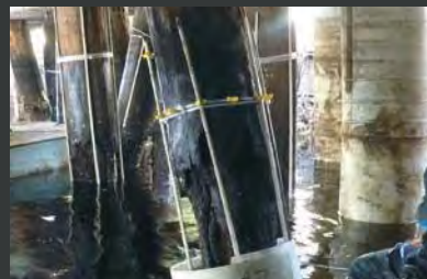
Espaciadores y barras de refuerzo de FRP unidas al pilote.
