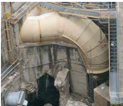
Compuerta de acero de 90 años con geometría desafiante reparada con CFRP.
