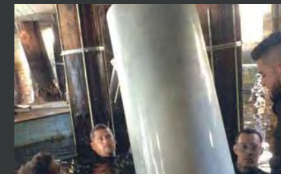
Chaqueta PileMedic® instalada antes de colocar el grout.
